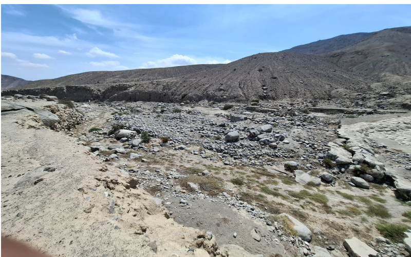
COLMATACIÓN DE DIQUE 5, AGUAS ABAJO
