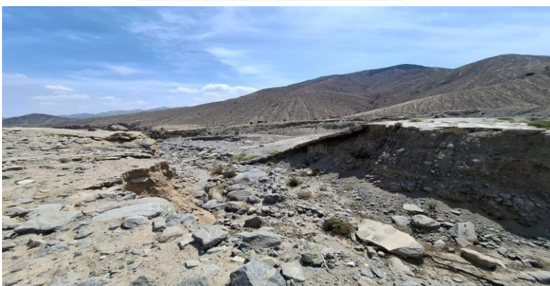
COLMATACIÓN DE DIQUE 4, AGUAS ABAJO
